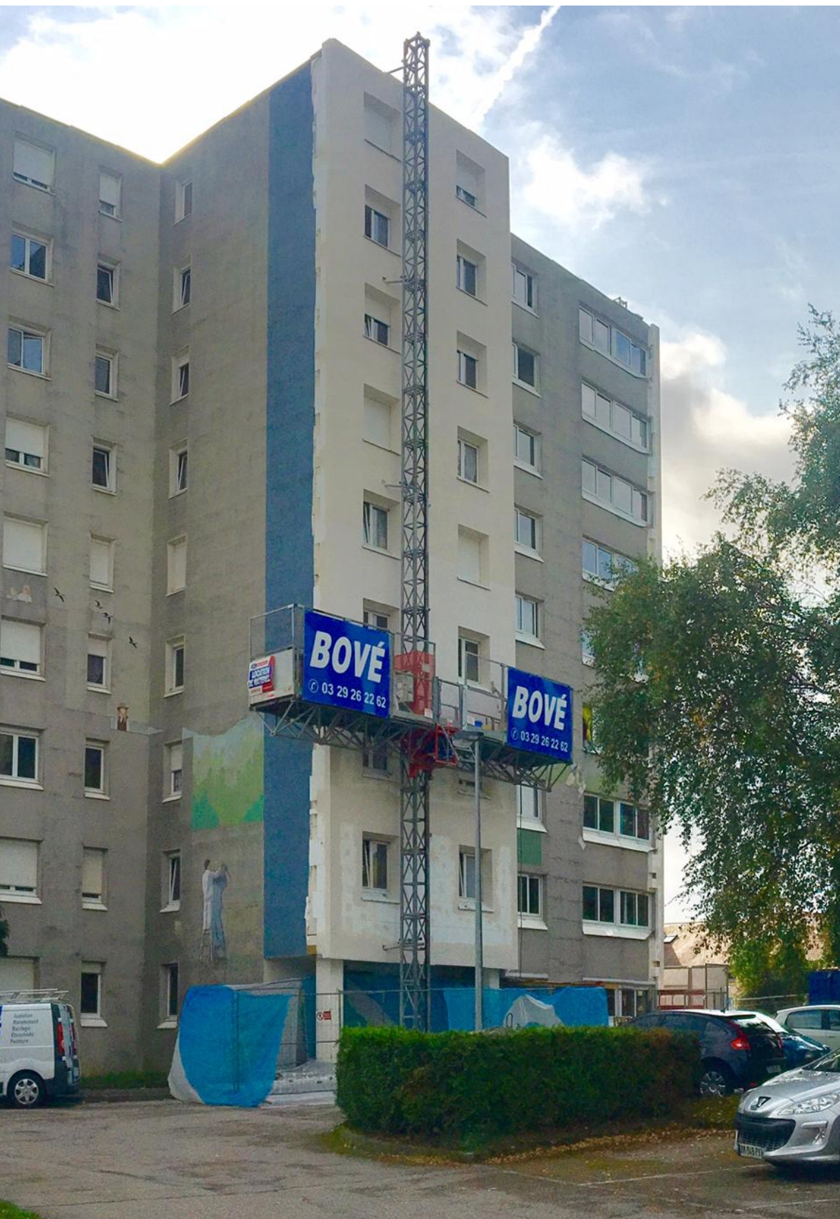
Sur cette tour de 9 étages, l'entreprise Bové a installé trois nacelles de chantier qui facilitent le travail de ses salariés tout en gagnant en productivité. Photos Richard RASPES.
